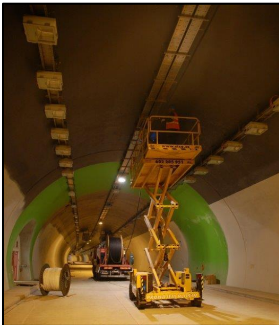
Obrázek 4: Instalace vyzářovacího kabelu v silničním tunelu Klimkovice
